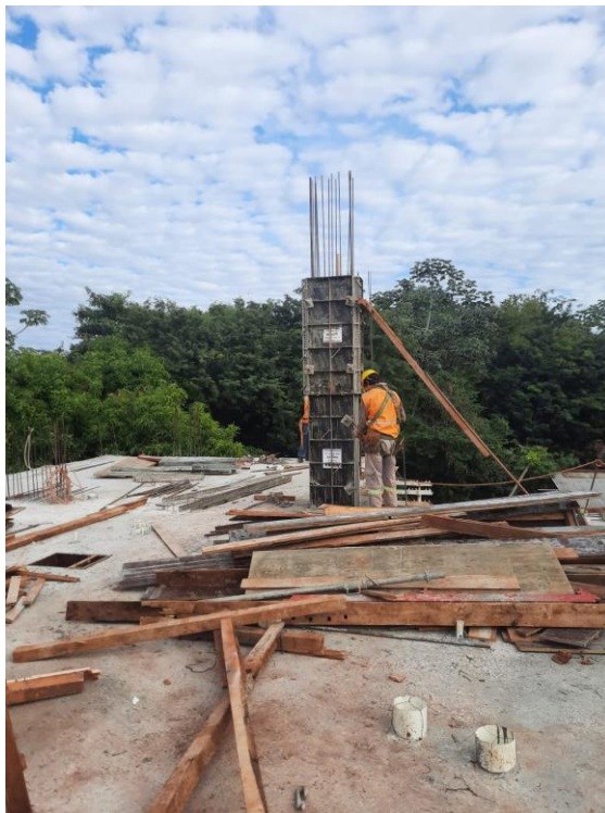
Armado, encofrado y hormigonado de pilares N1
