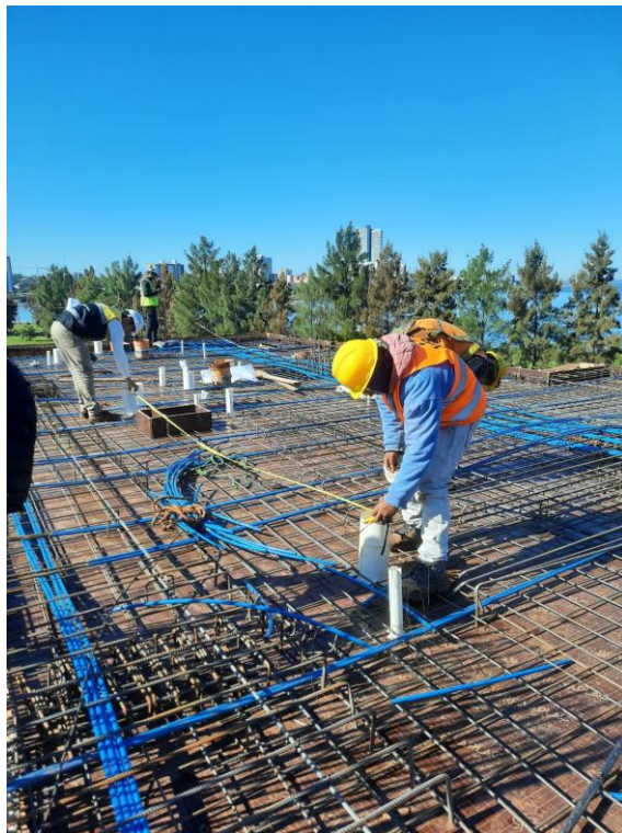
Instalación de pasantes y cabos
