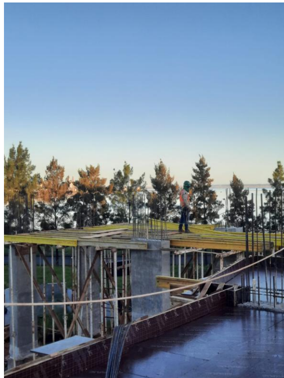
Encofrado de losa
